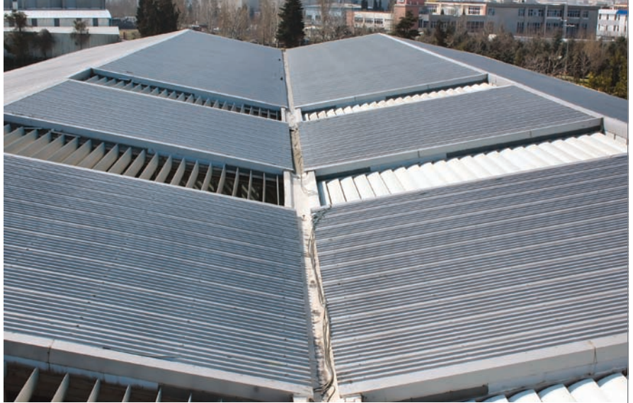
Güneş pozisyonu ve iklim koşullarına göre otomatik pozisyonlarını ayarlayan gölgelendirici kanatlar
